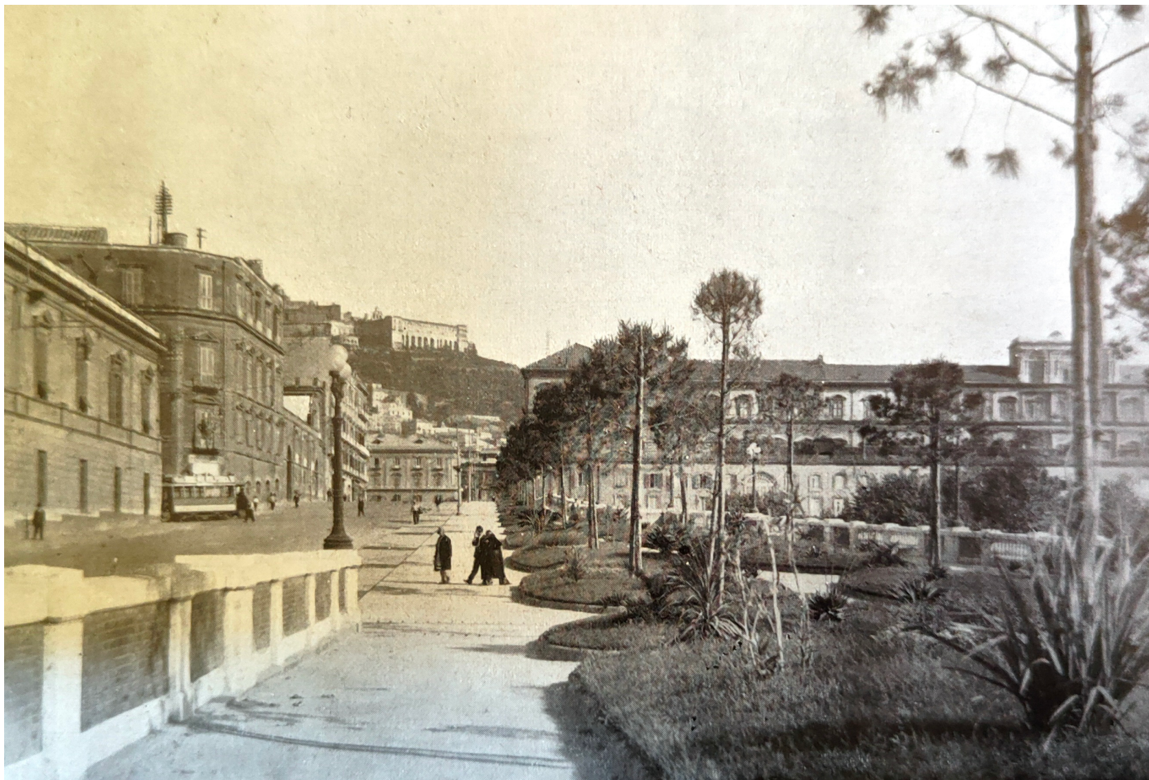
Fig. 1: Allargamento di via Nazario Sauro (Alto Commissario 1930, 117).
