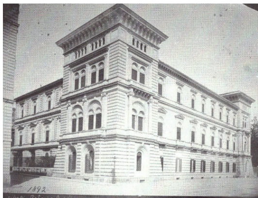
Fig. 5: Palazzo Sirignano alla Riviera di Chiaia. La data 1892 è apposta in basso a sinistra a mano dall'autore. Lastra gelatina al bromuro di argento 13x17,8 cm [Archivio storico fotografico di Giuseppe Caravita di Sirignano. Proprietà Fondazione Leonetti].
