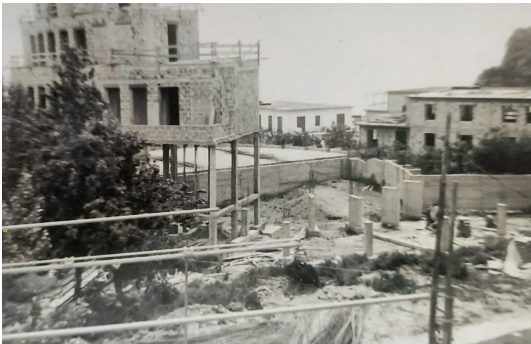
Fig. 9: Cantiere della parrocchia di San Giocchino, 1971-1972 [Bacoli. Archivio parrocchiale di San Giocchino].
