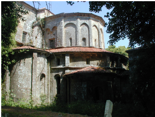
Fig. 4: Vista general de la cabecera de la Iglesia del Monasterio.
