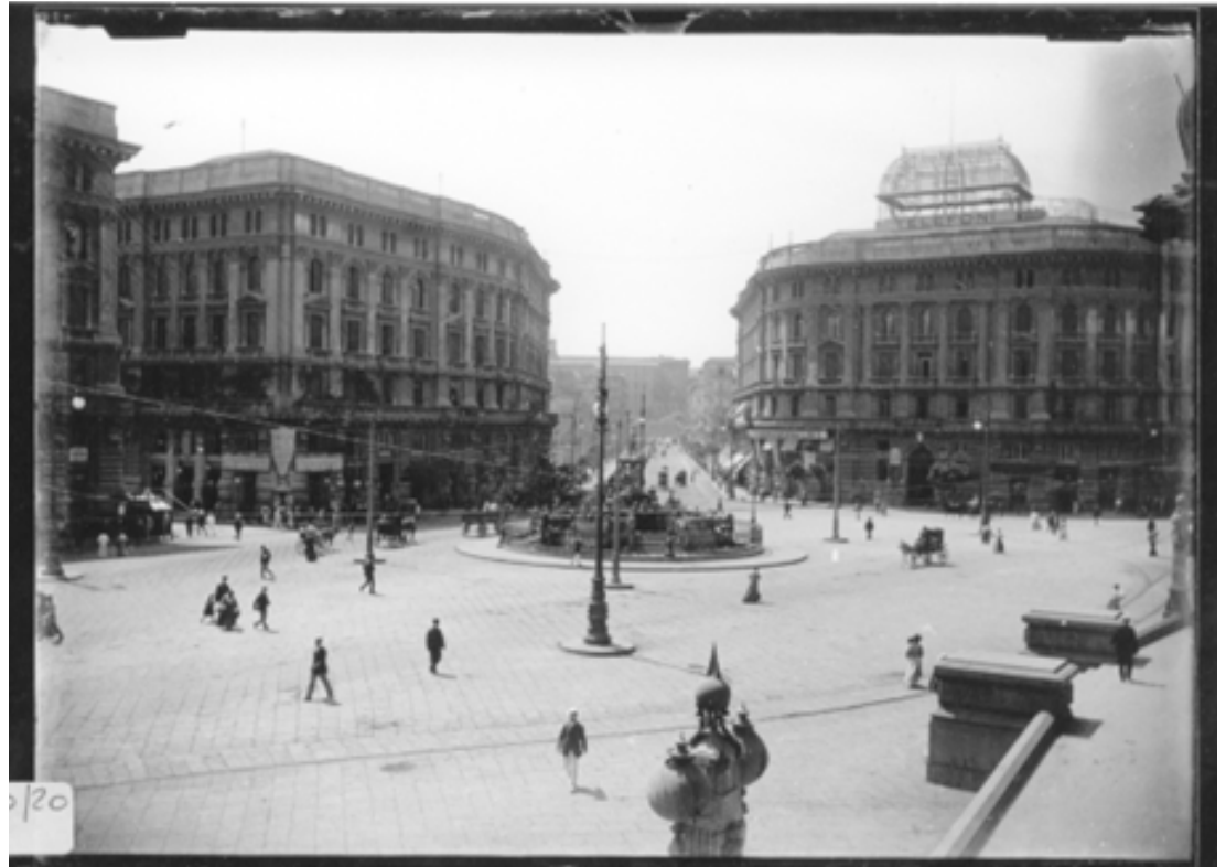
Fig. 14: Anonimo, Piazza della Borsa e via Depretis in costruzione , s.d. (Napoli. Archivio storico Stazione zoologica. Fondo SZN, Ld.133.220/20).
