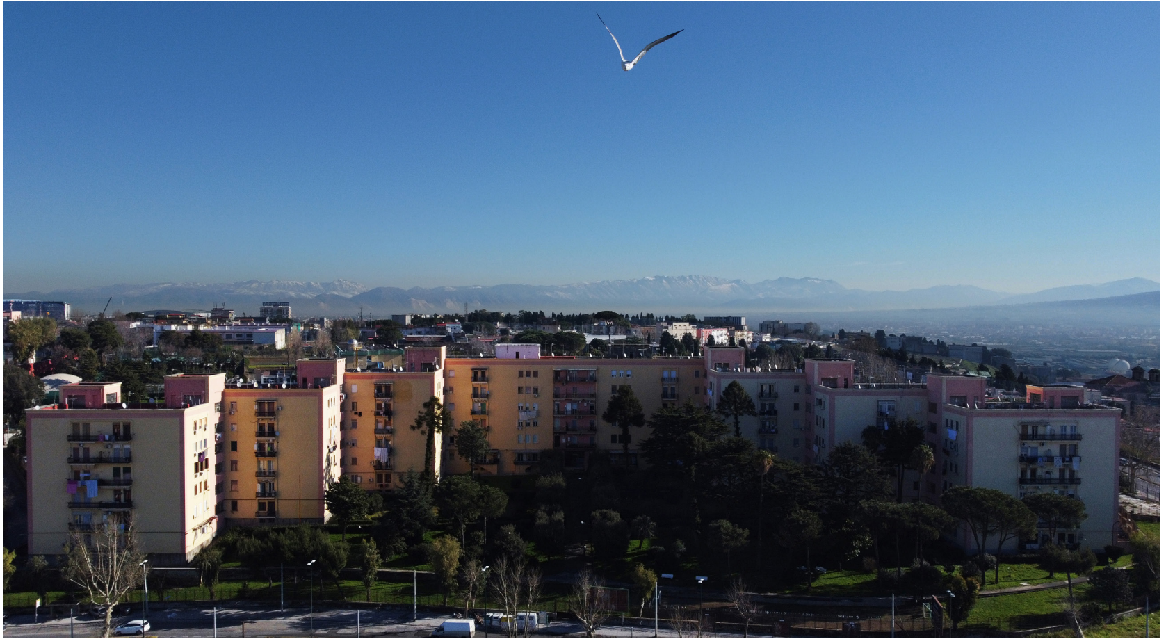
Fig. 15: Prospetto orientale delle ex-case delle Manifatture cotoniere meridionali, 2021 (foto da drone degli autori).
