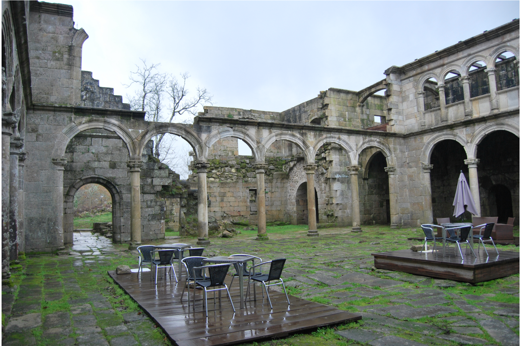
Fig. 12: Claustro de la Hospedería.
