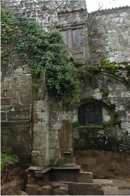
Fig. 9: Estructura de consolidación del Claustro Reglar.
