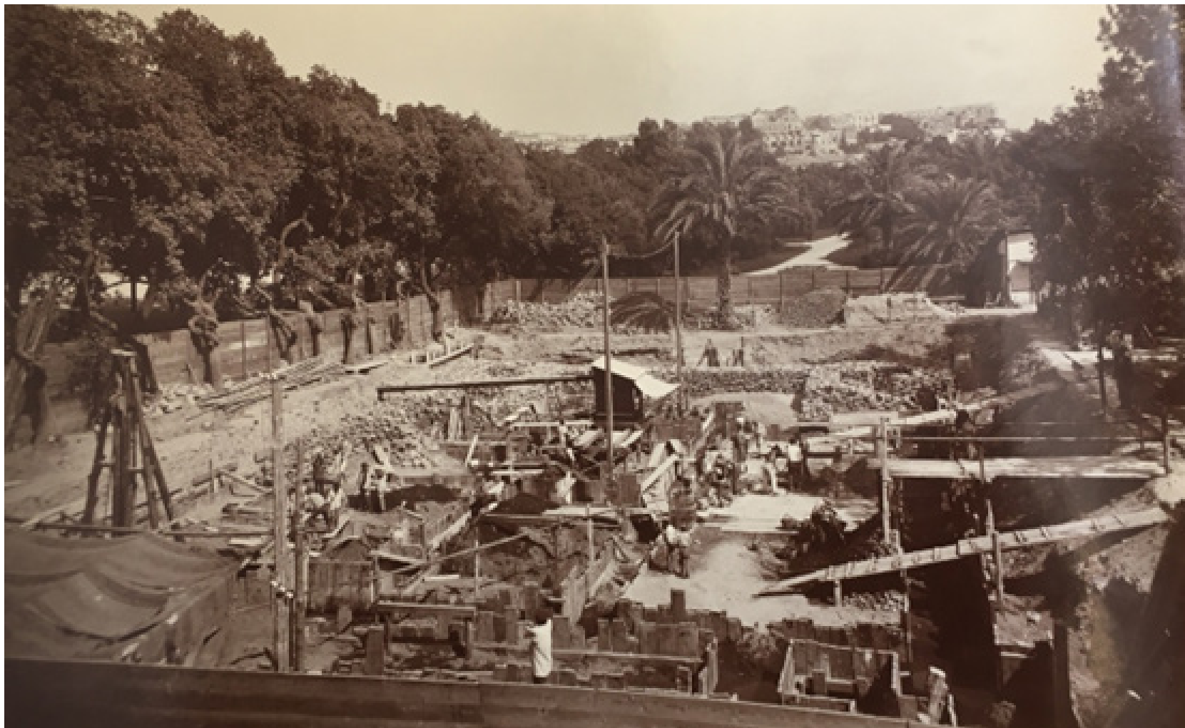
Fig. 11: Emil Schöbel, Cantiere del terzo edificio della Stazione zoologica , 1903-1905 (Napoli. Archivio storico Stazione zoologica. Fondo SZN, G.IV.135.19).
