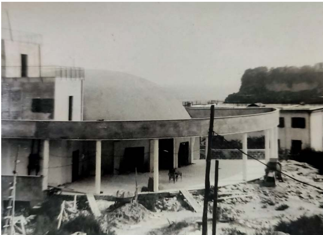
Fig. 10: Cantiere della parrocchia di San Gioacchino, chiesa, 1971-1972 [Bacoli. Archivio parrocchiale di San Gioacchino].
