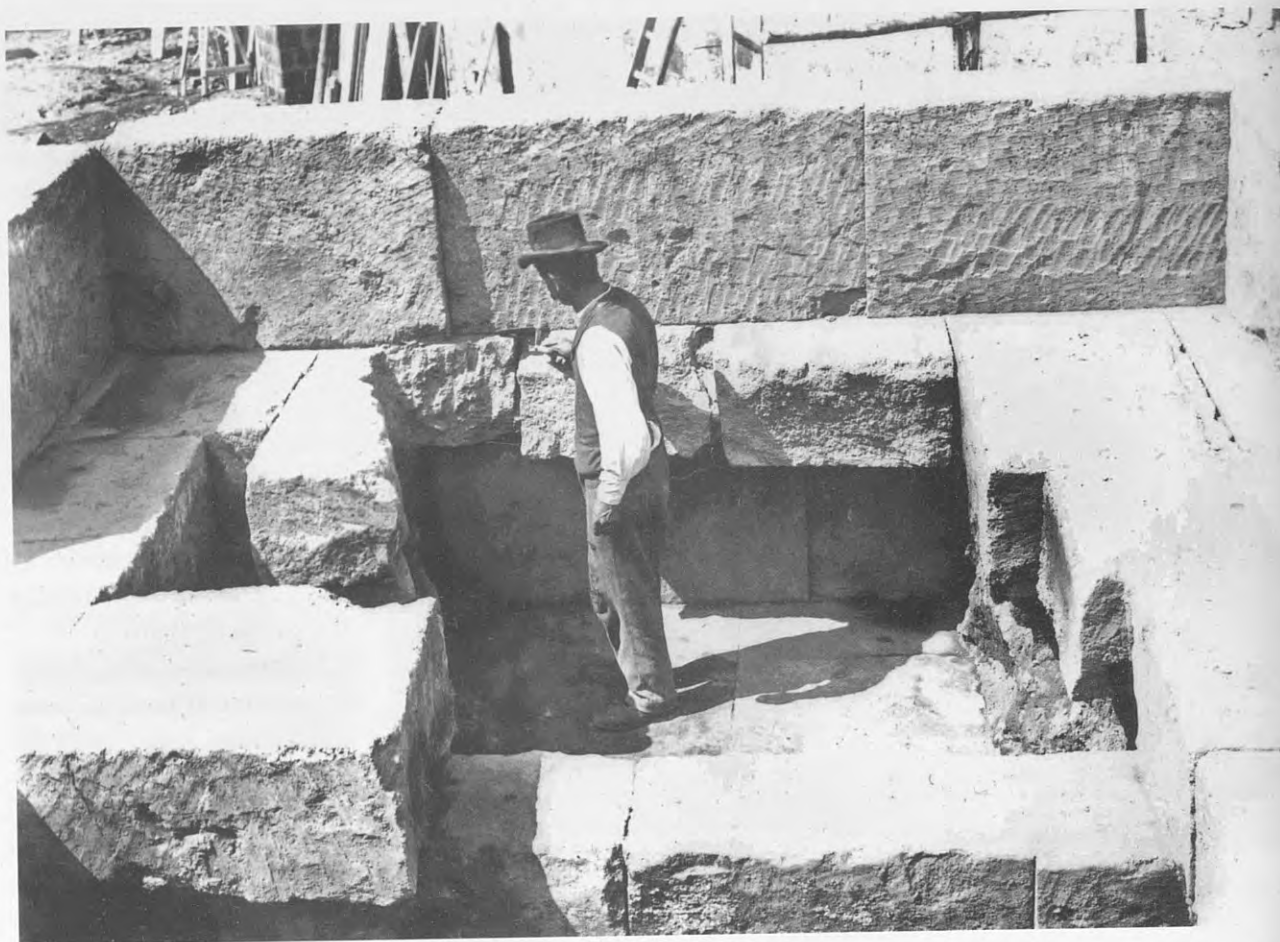
Fig. 12. Piazza Calenda. Veduta della torre da est in cui si può osservare il sistema dell'alternanza dei filari in assise e piane, messi in opera in modo da costituire una platea unitaria, e di quelli in ortostati foderati da un emplekton . (1910, inv. 3773).
