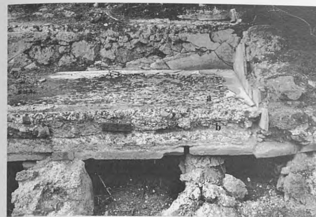
Fig. 12. Settore maschile, Calidarium , alveus/solium : sovrapposizione di due pavimentazioni in cocciopesto.
