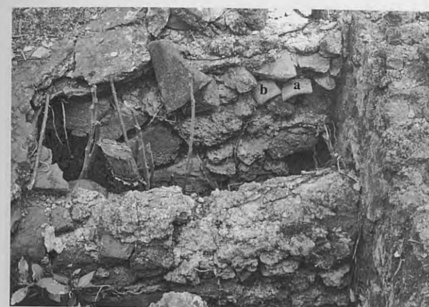
Fig. 15. Settore femminile, Calidarium : materiale ceramico reimpiegato nella costruzione delle suspensurae dell' alveus/solium .
