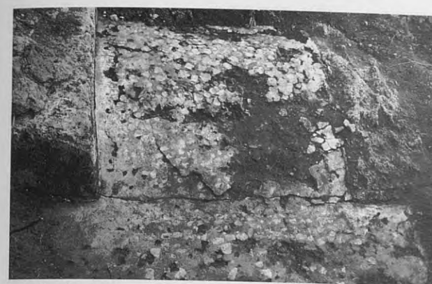
Fig. 8. Settore maschile, Tepidarium : particolare del pavimento in cocciopesto e della soglia di accesso al calidarium .
