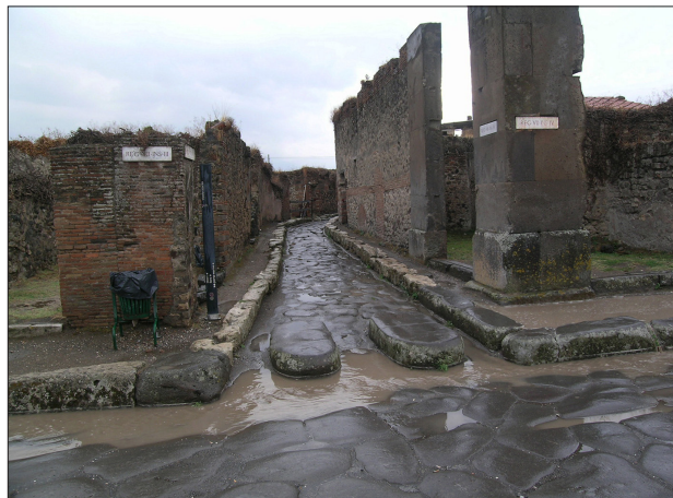
Fig. 5. Pioggia a Pompei, incrocio fra Via della Fortuna e Vicolo Storto. Le differenti pendenze delle strade permettono di isolare e proteggere dall'allagamento l'area centrale della città.
