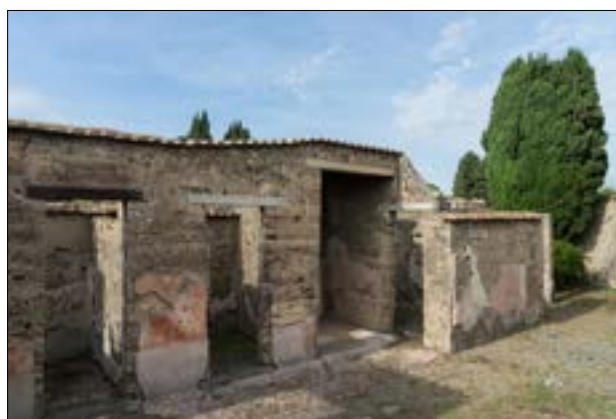
Fig. 1. Pompei, Casa del Chirurgo (VI, 1, 10.23), atrio, muri in opera quadrata di travertino.
