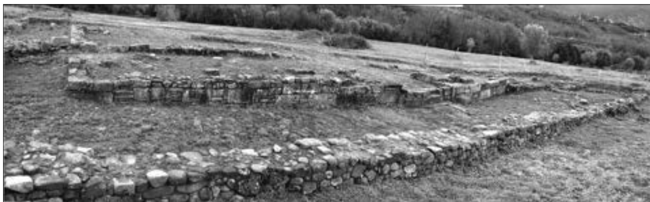
Fig. 5. In primo piano il muro che restringe la Plateia A e in secondo piano il muro in tecnica a scacchiera dell'Edificio II o Casa in tecnica a scacchiera.
