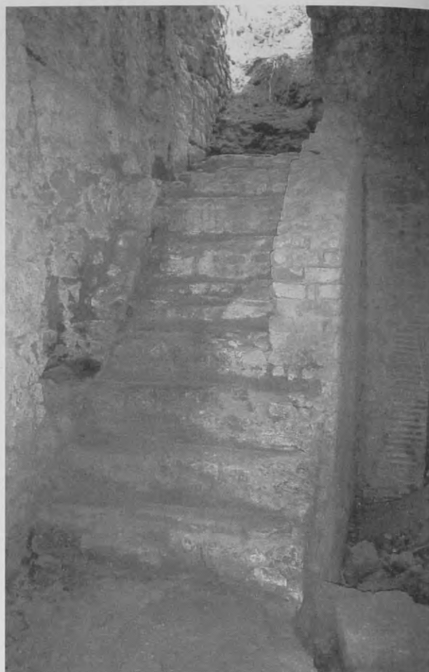
Fig. 13. Cuma, Terme Centrali: scala dell'ambiente F fotografata da ovest.
