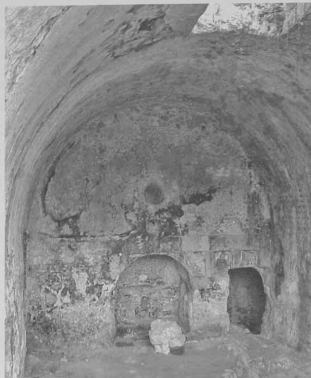
Fig. 7. Cuma, Terme Centrali: l'ambiente A visto da ovest.
