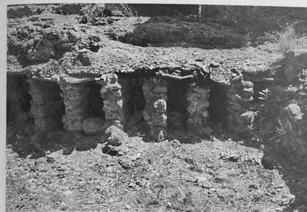
Fig. 14. Settore femminile, Calidarium : particolare delle suspensurae a muretti di opera incerta.
