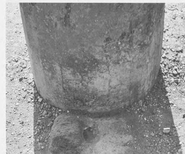
Fig. 10. Ingresso di via di Porta Marina nel Foro: resti di un sistema di chiusura.
