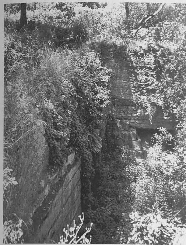
Fig. 2. Tempio B, lato nord: particolare delle strutture di fondazione del tempio e della sottostante cortina muraria.
