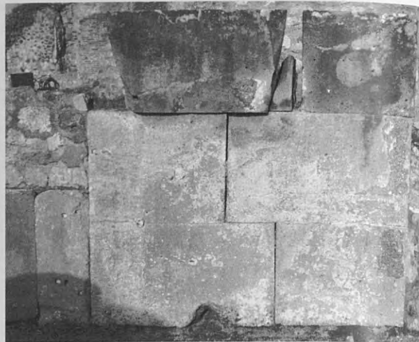
Fig. 5. Fronte del «Comizio» verso il Foro: resti di grappe di fissaggio.
