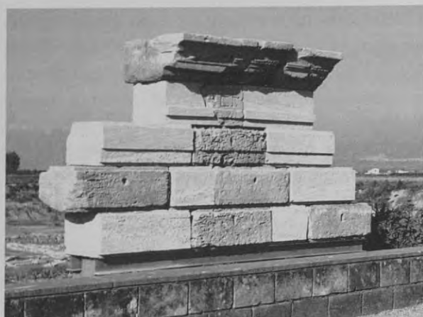
Fig. 36. Anastilosi parziale della parte sommitale della porta (paramento e trabeazione). Febbraio 2001.
