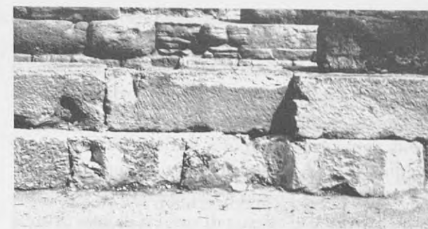
Fig. 31. Semi-rocchi di colonna dorica reimpiegati nel paramento del pilone occidentale. Le scanalature sono state parzialmente scalpellate al fine di acconsentire un maggiore accostamento con i blocchi attigui.
