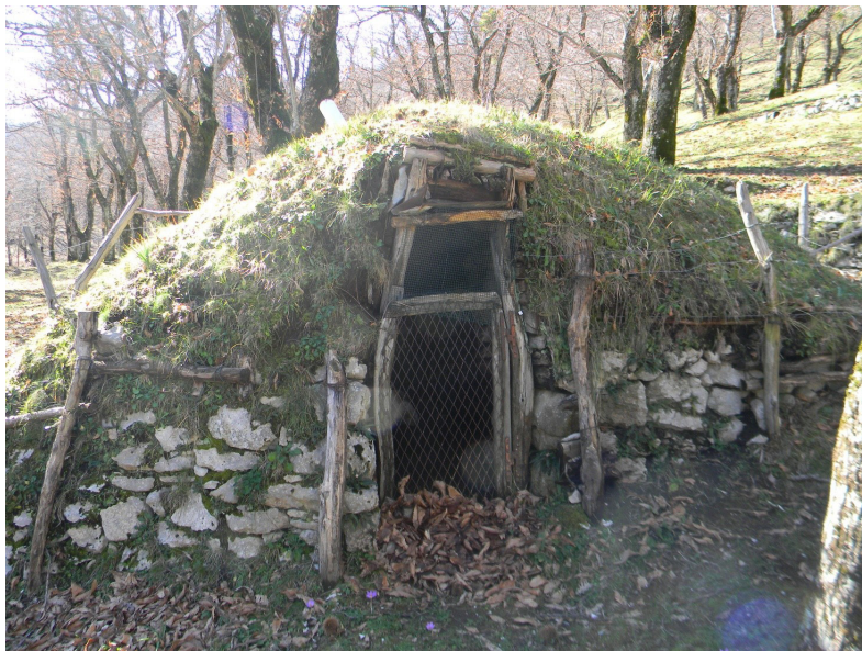
Fotografia 44 – Ingresso di un pagliaro in pietra ricoperto di terra ed erba (cfr. témba ).
