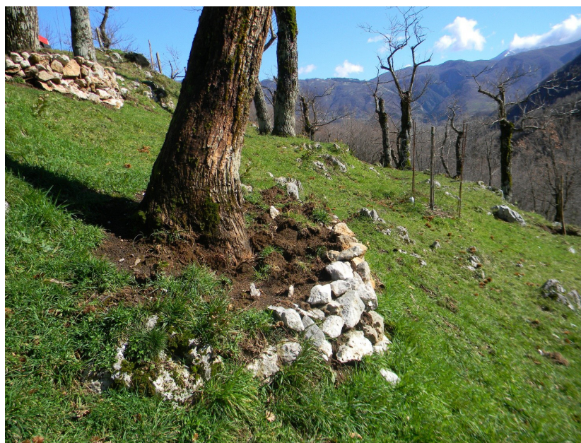
Fotografia 37 - re lunette realizzate in pietra.
