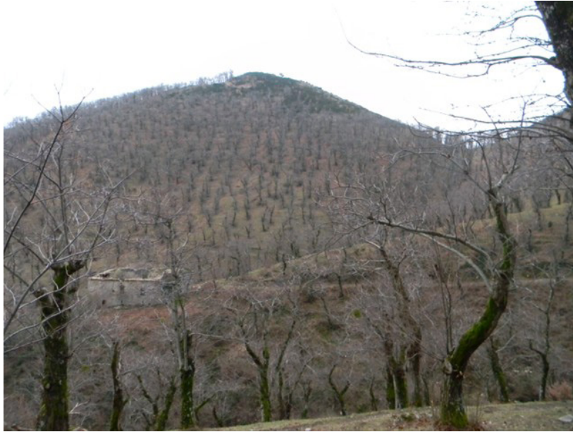
Fotografia 59 – Purcìno in rovina con tetto crollato.
