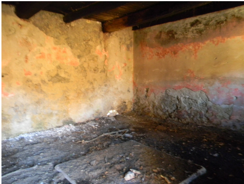
Fotografia 32 – Piano terra del gratàle , dove veniva acceso il fuoco per la lenta essiccazione delle castagne poste sopra il graticciato di legno.
