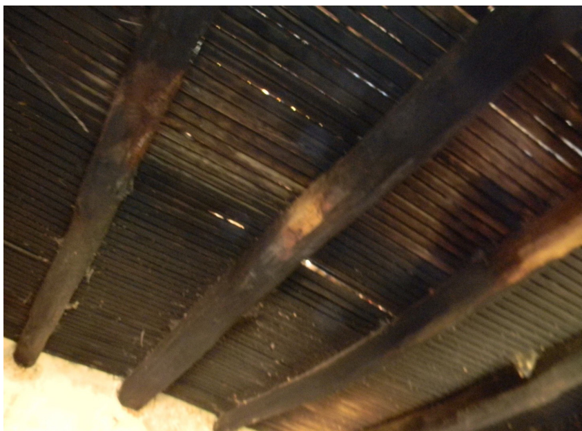
Fotografia 33 – solaio del gratàle , cioè la gràte .
