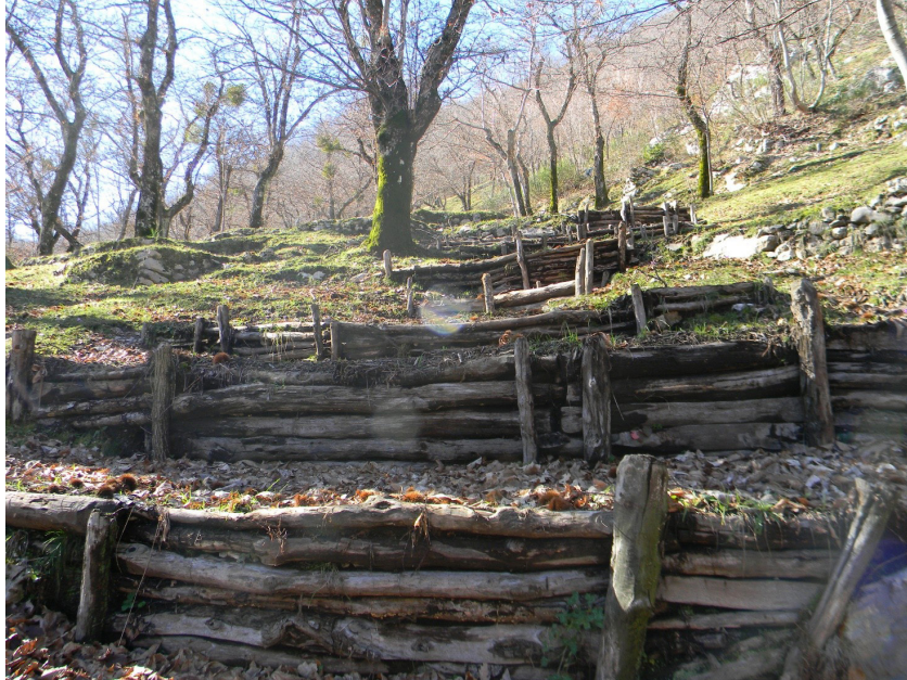
Fotografia 38 – Serie di marrizze realizzate in prossimità di un vallone
