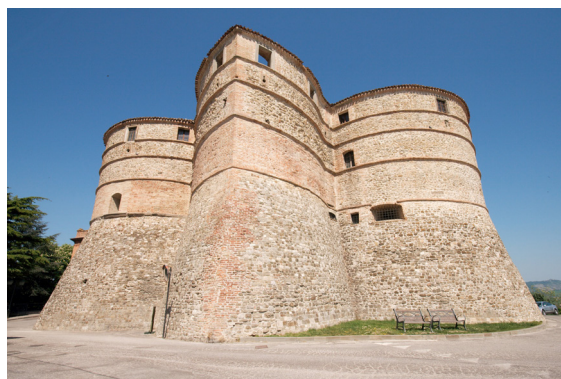
Fig. 10 – Torrione con un impianto 'a becco di sprone' della Rocca di Sassocorvaro, progettato da Francesco di Giorgio, ca. 1475 (Foto Dino Quinzani)
