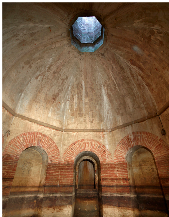
Fig. 2 – Giuliano da Sangallo, camera ottagonale ventilata da un oculo nella volta, ca. 1512. Pisa, Cittadella Nuova, interno del Bastione di San Martino, (Foto Mario Ciampi)
