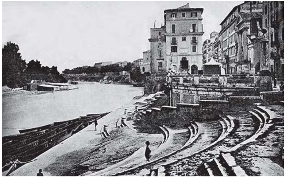
Il porto di Ripetta alla fine dell'Ottocento. La costruzione dei muraglioni lungo il Tevere fu la scelta tecnica fatta per evitare i continui allagamenti della città. L'area nella foto è quella che oggi ospita il museo dell'Ara Pacis di Richard Maier.
