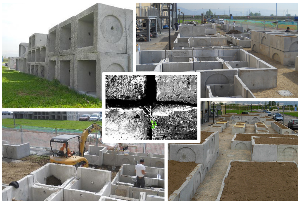
Fig. 4 – I fase della realizzazione: assemblaggio dei pozzetti prefabbricati (fotografie e immagini dell'autore con S. Carbone)
